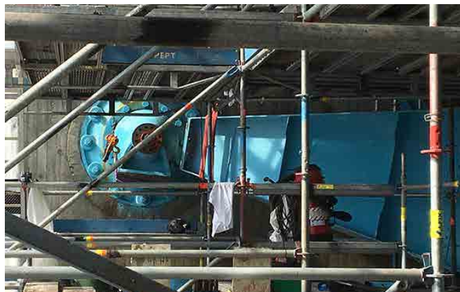
Un lato della tenuta prima dell'installazione della paratoia.
